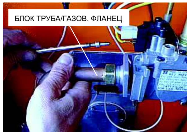
Рисунок 24 – Блок труба/газовый фланец
