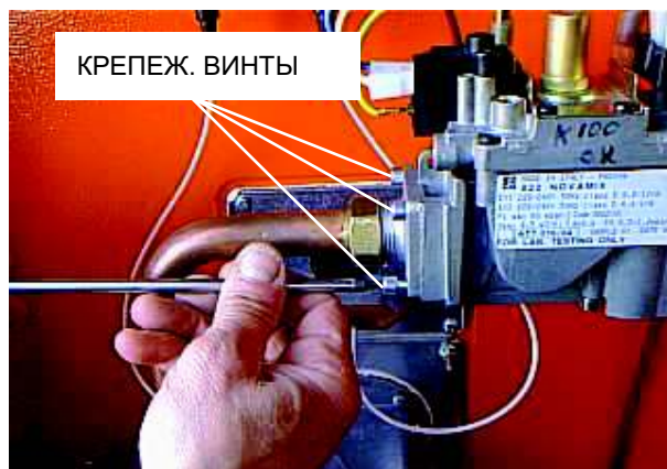
Рисунок 23 – Крепежные винты газового фланца
